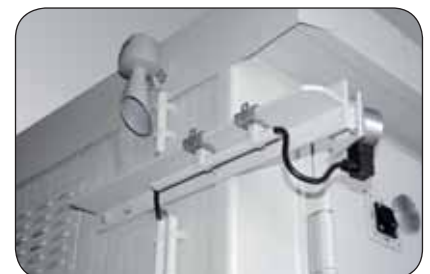
Ex-geschützte Abluftüberwachung mit Signalhupe und Türhalteanlage
