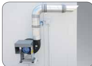
Ex-geschützter Abluftventilator inkl. Abluftüberwachung
