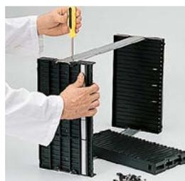
Befestigung der Seitenwände
